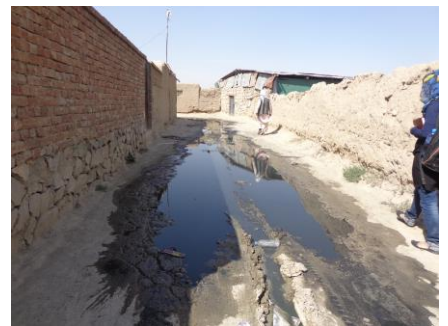
تخلیه فاضلاب تصفیه نشده در کوچه‌ها و سرک‌ها: عدم موجودیت اتصال به سیستم تصفیه فاضلاب متمرکز.
